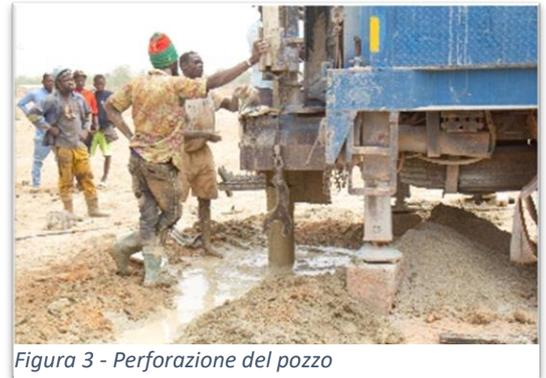
Figura 3 - Perforazione del pozzo
